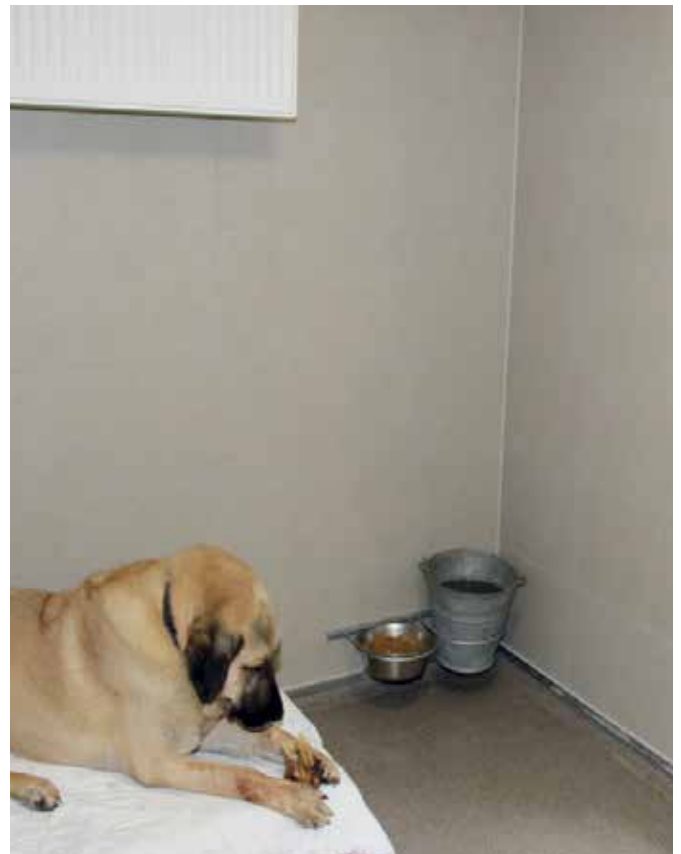
Innenzwinger des sanierten Hundehauses mit erhöhter Liegefläche und Bodenheizung
